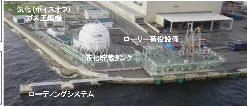
Hytouch神戸には、 $-253^{\circ}\text{C}$ で体積を1/800にした極低温の液化水素を長期間、安定的に貯蔵する国内最大の2,500m球形液化水素貯蔵タンク(容量2,250m<sup>3</sup>)や液化水素専用船陸間移送ローディングアームなどが設置されている。
