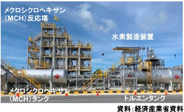
○資源国で生産した水素とトルエンを化学反応によりMCH(メチルシクロヘキサン)とし、常温常圧で液体の物質に変換(水素化反応)して貯蔵輸送
